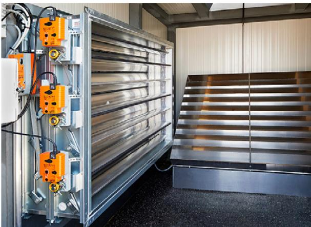
Abbildung beispielhaft: Druckentlastungsklappe
