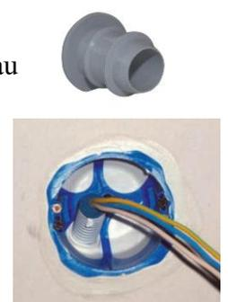
Lorsque le tableau électrique est hors volume chauffé, calfeutrer entre fourreau et câble avant la distribution en intérieur. Un bouchon étanche doit également être placé entre câble et fourreau arrivant à la sonde afin d'éviter les entrées d'air.
