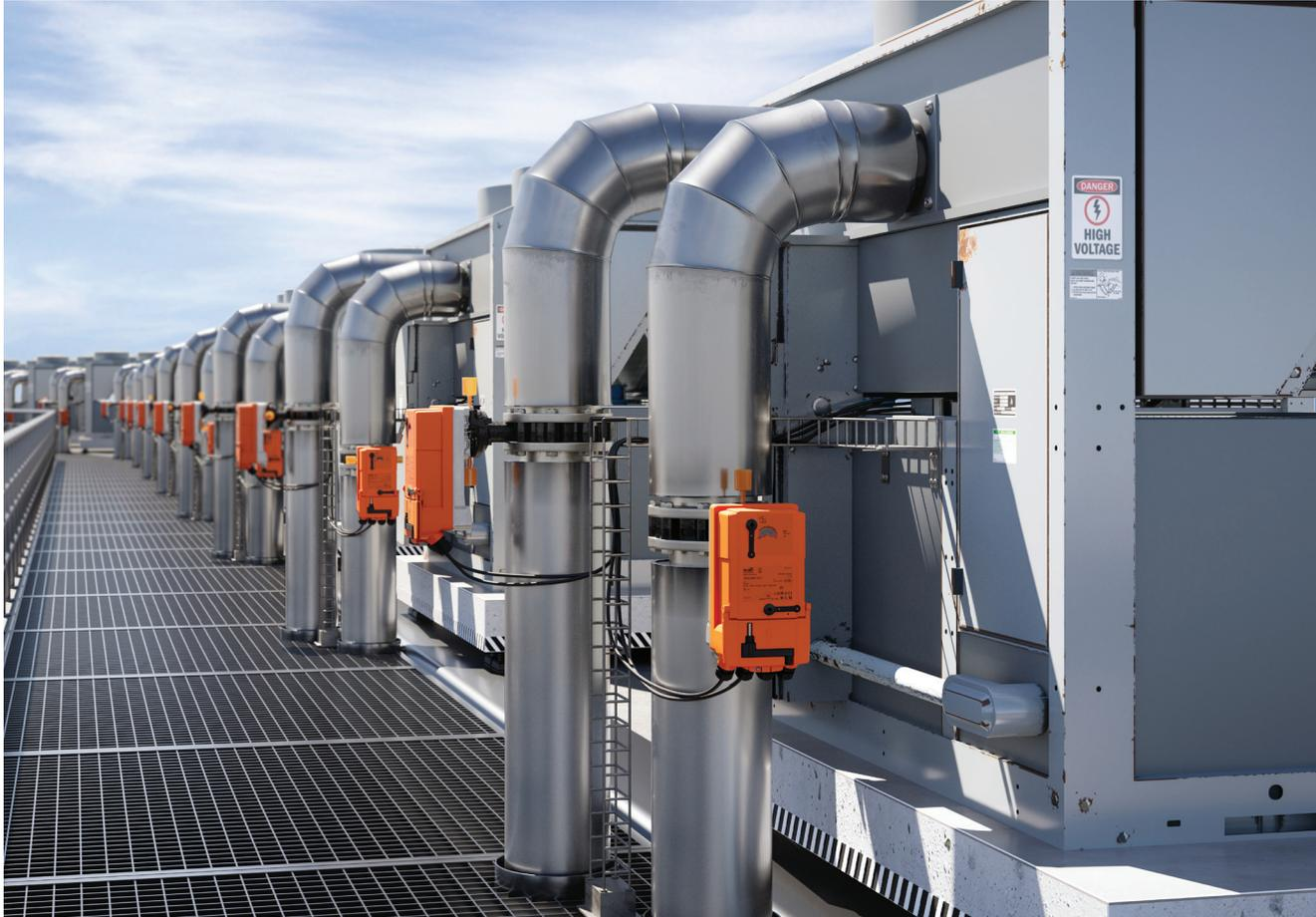
Les robinets à papillon sont des éléments essentiels des systèmes de essentiels des systèmes hydroniques. Malheureusement, la plupart des robinets à papillon sont loin de constituer une solution idéale – ils ne sont pas parfaitement étanches, leur durée de course n'est pas optimisée pour les installations de CVCA, ils sont lourds, difficiles à câbler et ne peuvent être activés rapidement.
